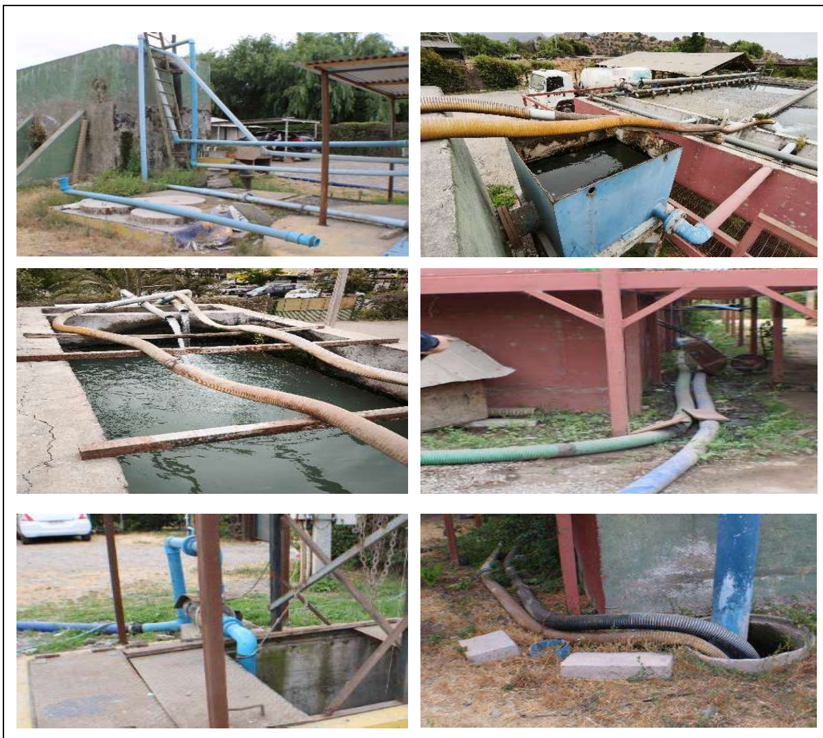
Imagen N°9: Modificaciones e intervenciones a la PTAS.
